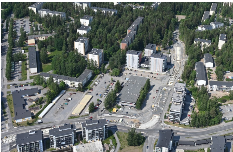
Kuva 1. Viistokuva kesältä 2023. Etualalla raitiotielinjan työmaa. Kuva: Suomen ilmakuva Oy.
